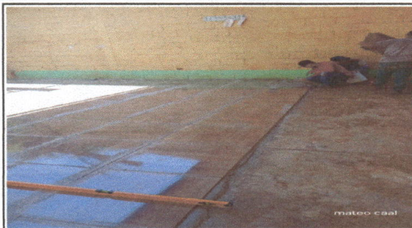
Foto 2: como se muestra en la fotografia el avance de la instalacion de piso ceramico
